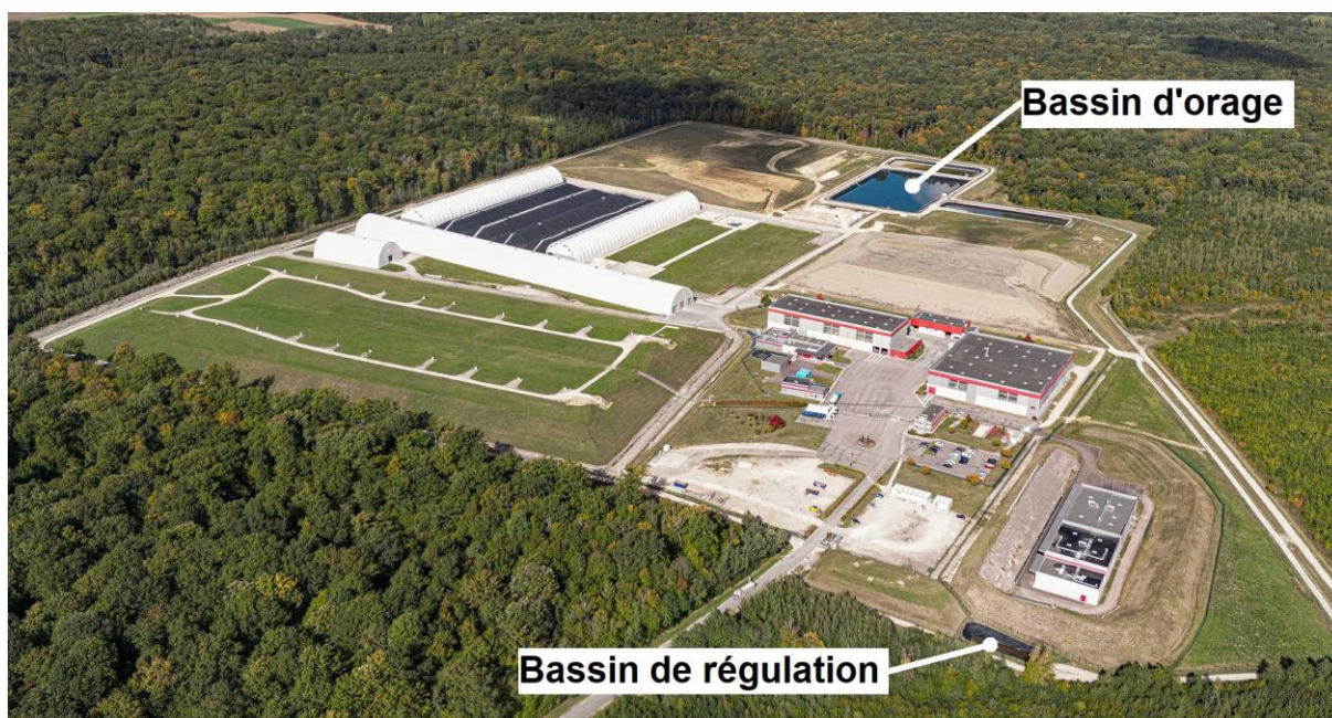
Figure 5-2 Vue aérienne du Cires - bassins d'orage et de régulation
